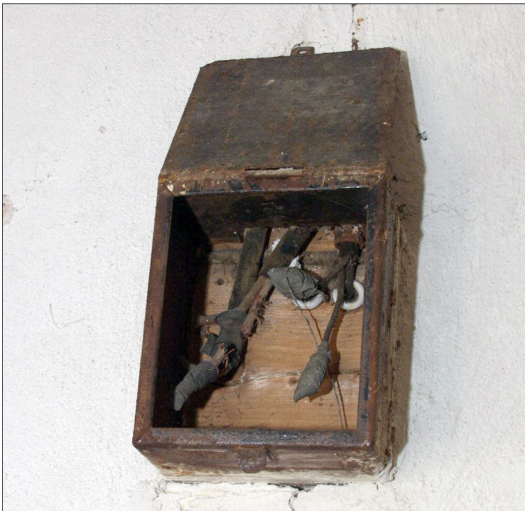
Majasisese elektriinstalatsiooni riismed ja vanaaegne elektrikilp Ristna sõjaväelinnaku elamus. Foto Mart Mõniste.
