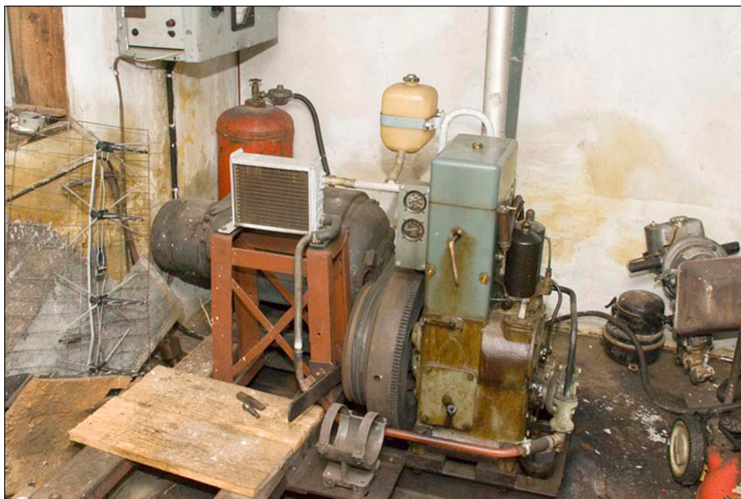
Noorkõivu talu elektrijaam Kõpu külas. Generaator on veel töökorras. Foto Mart Mõniste 2011.
